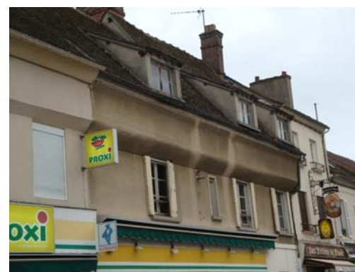
Exemple probable de pans de bois à encoffrement encoffré
