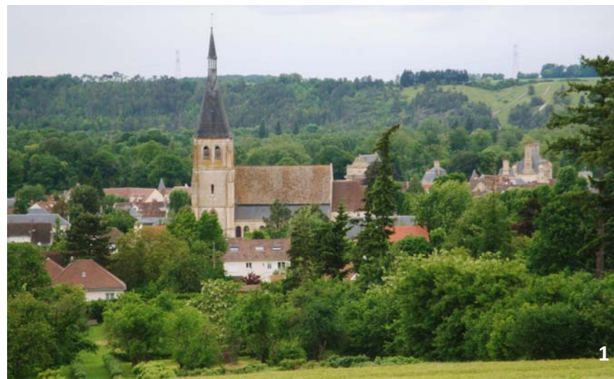
Vue de l'église dans son contexte urbain et paysager, sur fond des substructures du château, et perception forte du coteau nord, depuis le coteau sud
