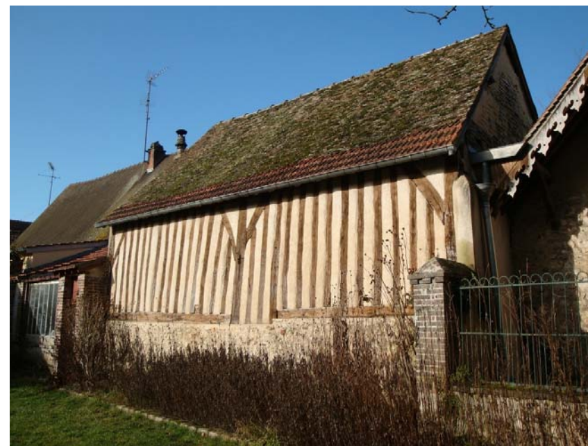
Mur de bâti annexe à pans de bois
