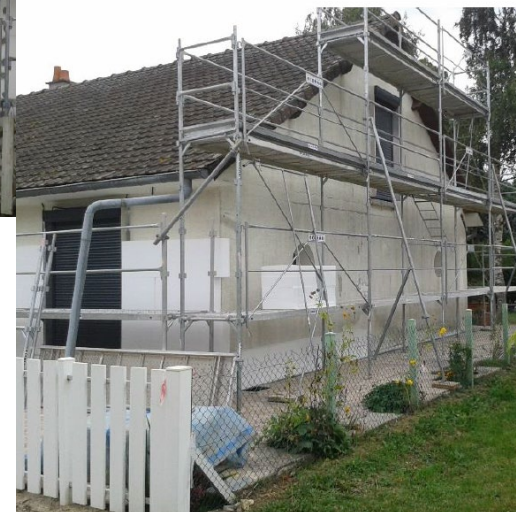
Isolation des murs par l'extérieur et isolation de la toiture
