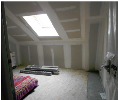
Isolation des murs par l'intérieur
