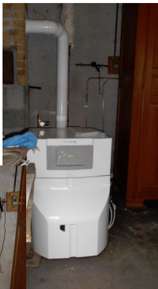
Remplacement d'une chaudière ancienne
