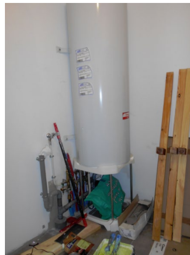
Remplacement d'un ballon d'eau chaude
