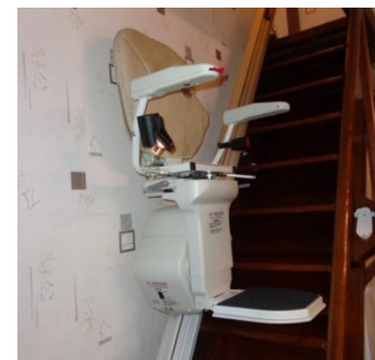
Installation d'un monte-escalier
