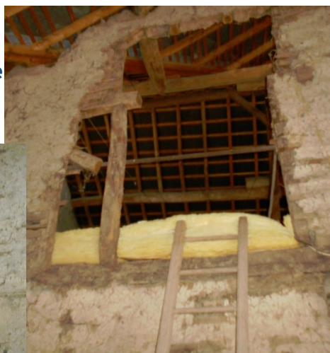
Isolation des combles perdus
